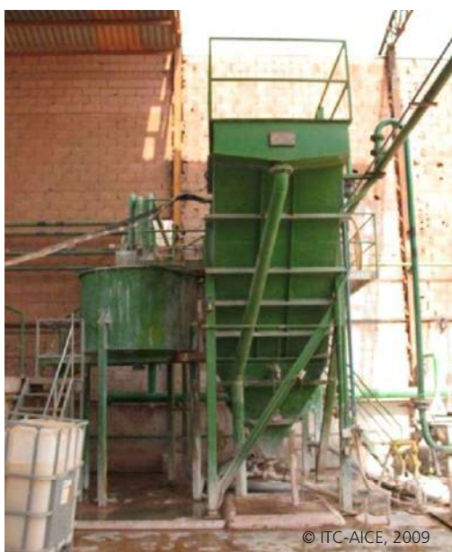
Figura 30. Sedimentador de lamelas.
